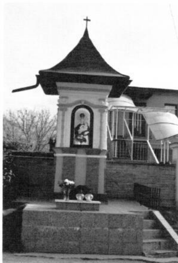
Obnovená kaplnka v roku 2018
