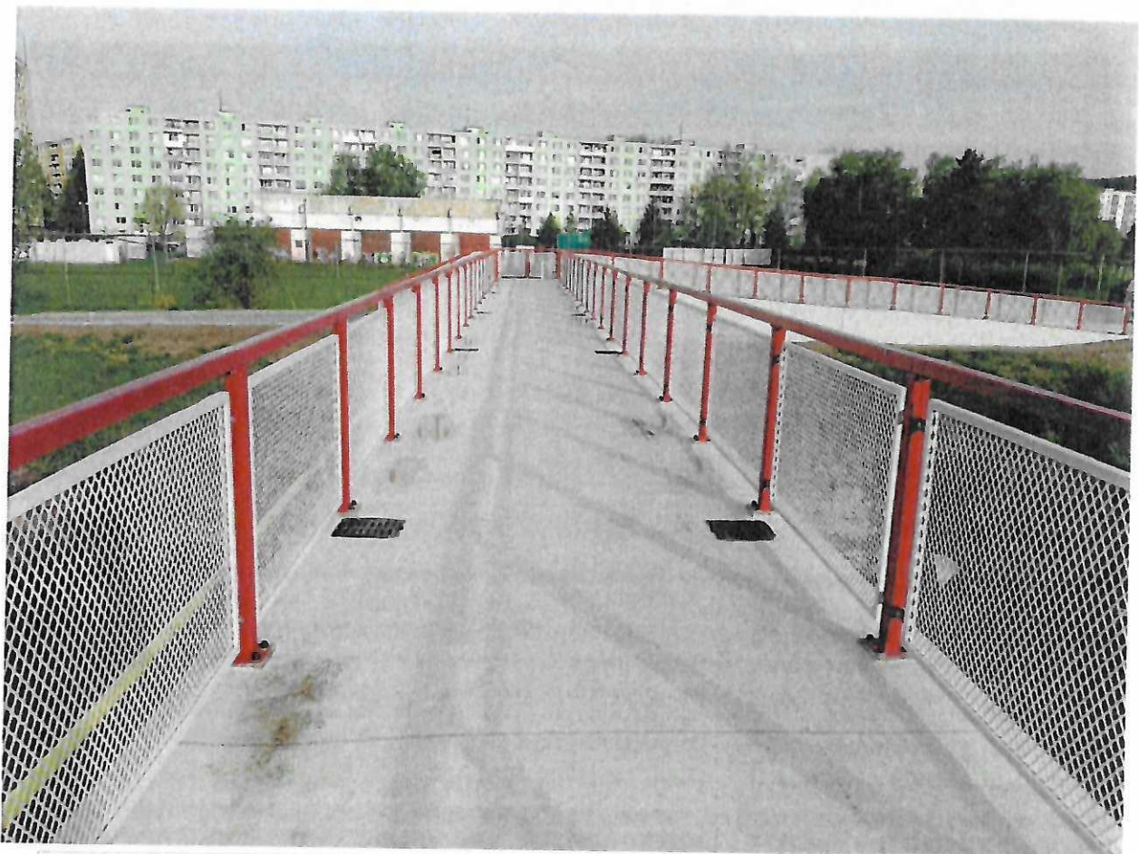
Obrázok 2: Prešov, rekonštrukcia lávky na ul. Mukačevská
