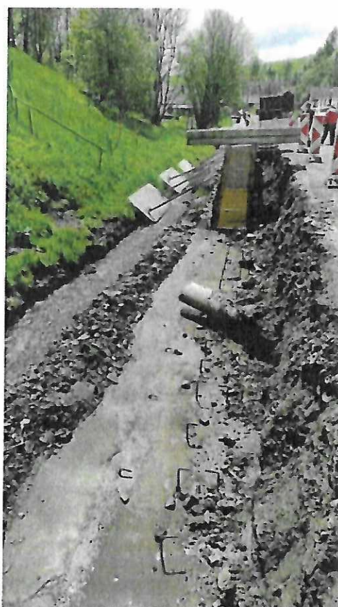
Obrázok 13: Oprava priepustu na cestách II. a III. triedy – Makovce, Havaj, Belejovce
