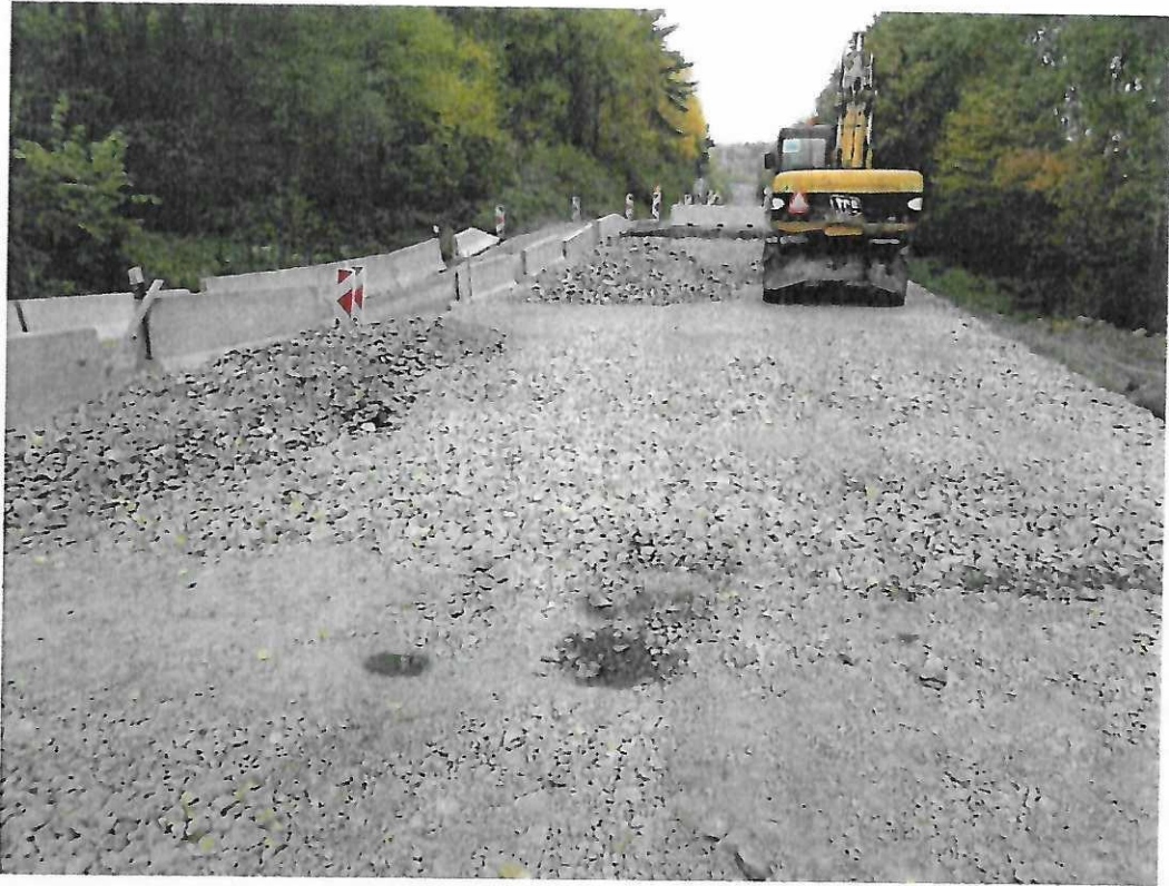
Obrázok 5: Rekonštrukcia priepustu na ceste III/3507 - Mihaľov
