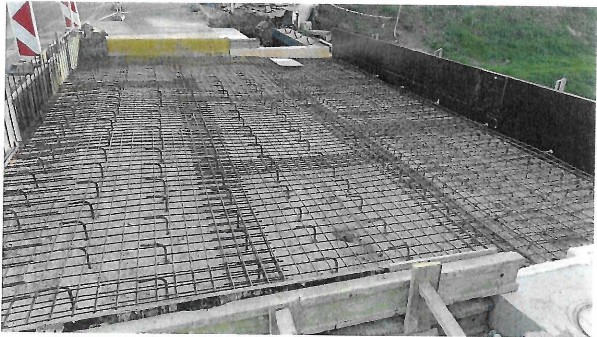
Obrázok 6: Rekonštrukcia mosta M1038 v obci Osikov
