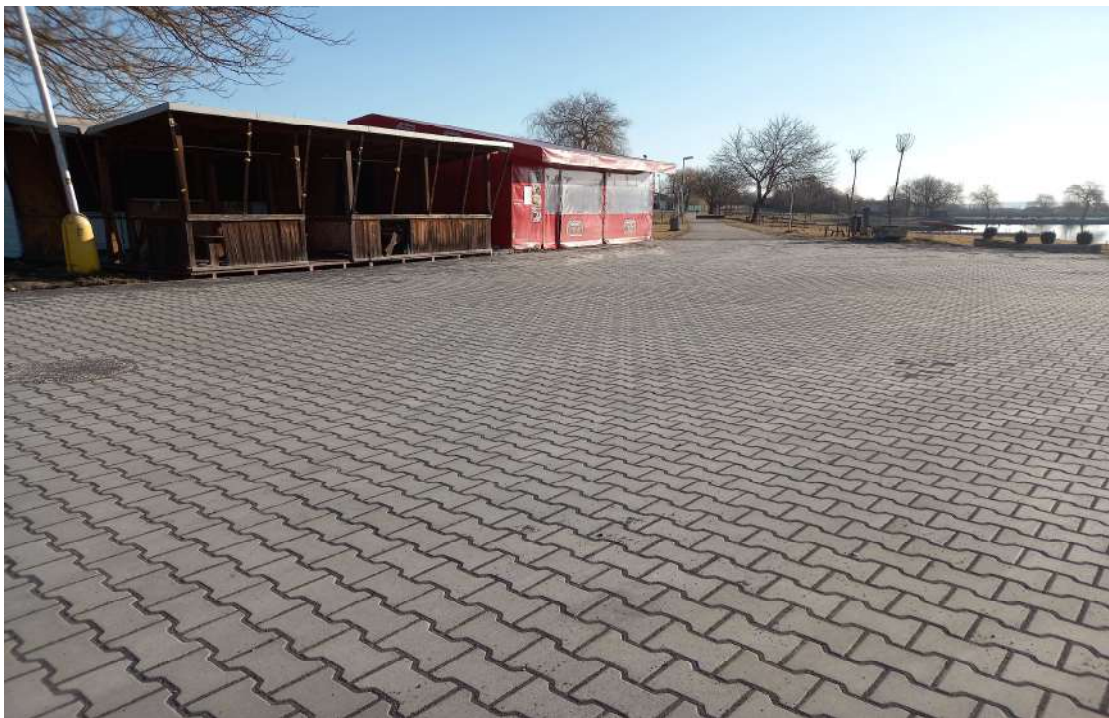
Obr. Rekonštrukcia chodníkov RO
