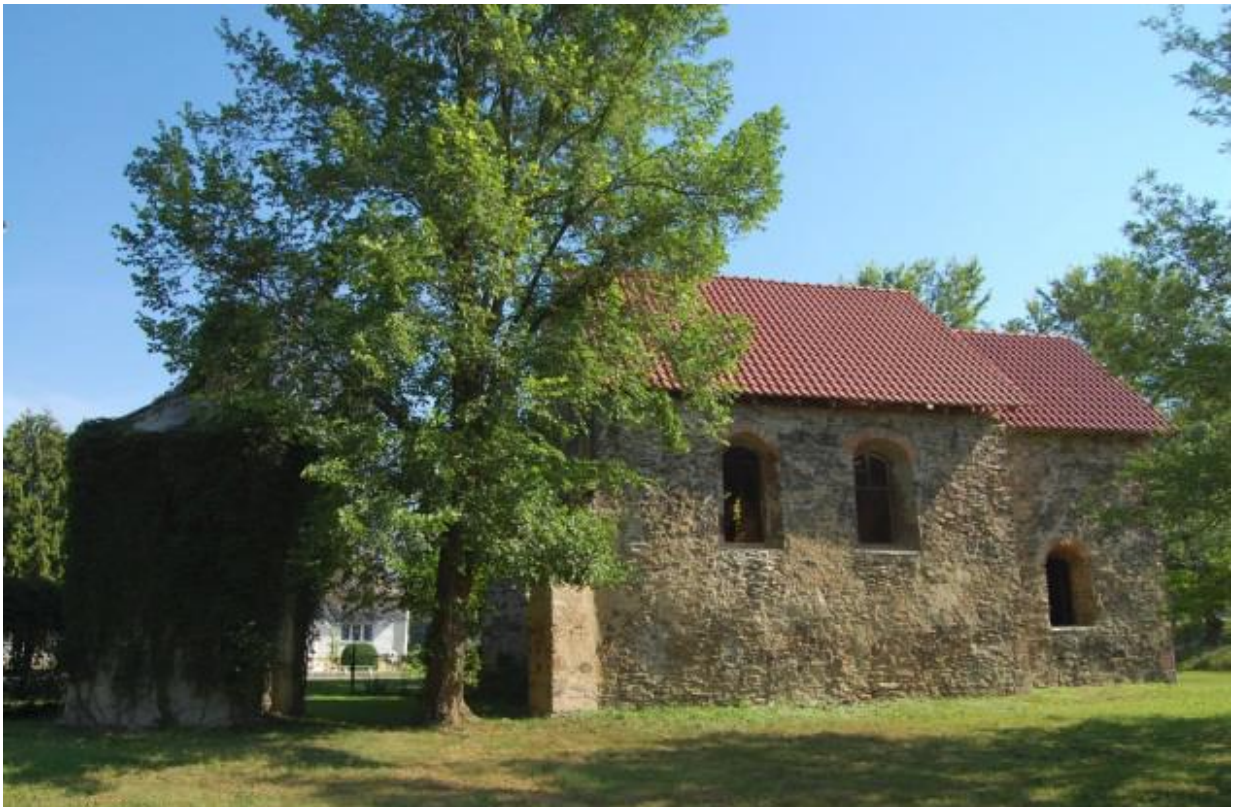
Obrázok 6 Rímsko-katolícky kostol po rekonštrukcii
