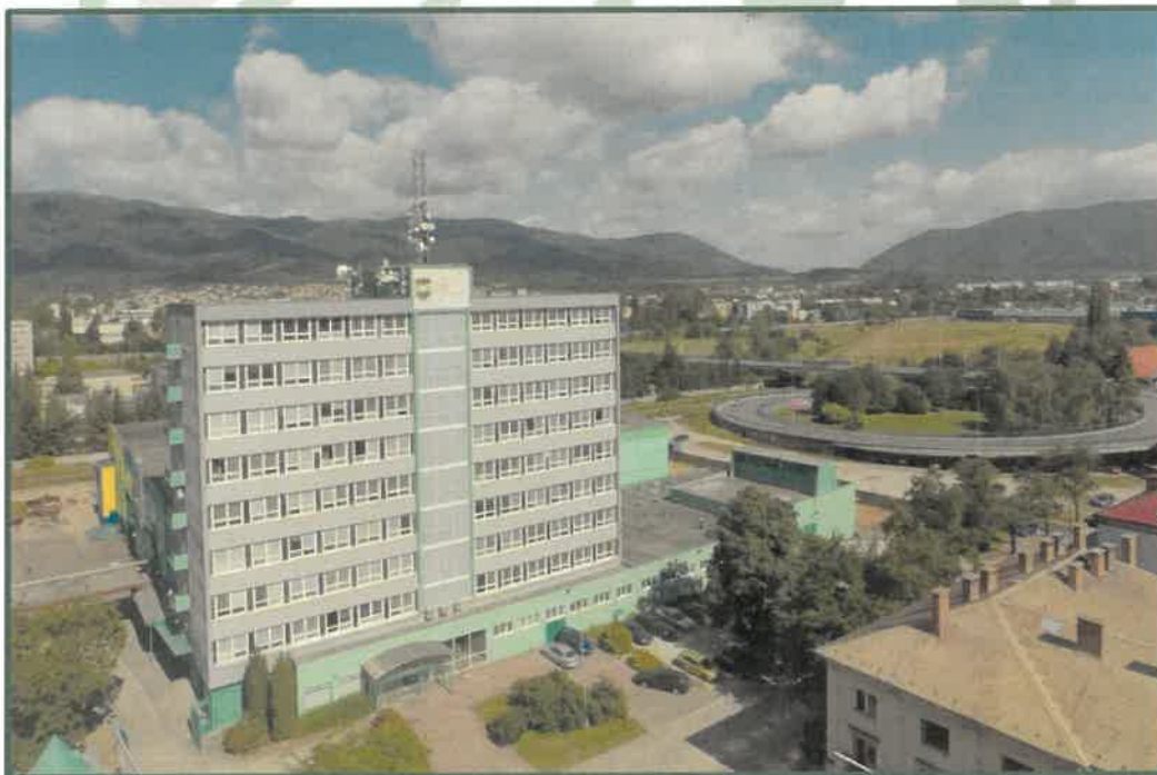
Pohľad na administratívnu budovu
