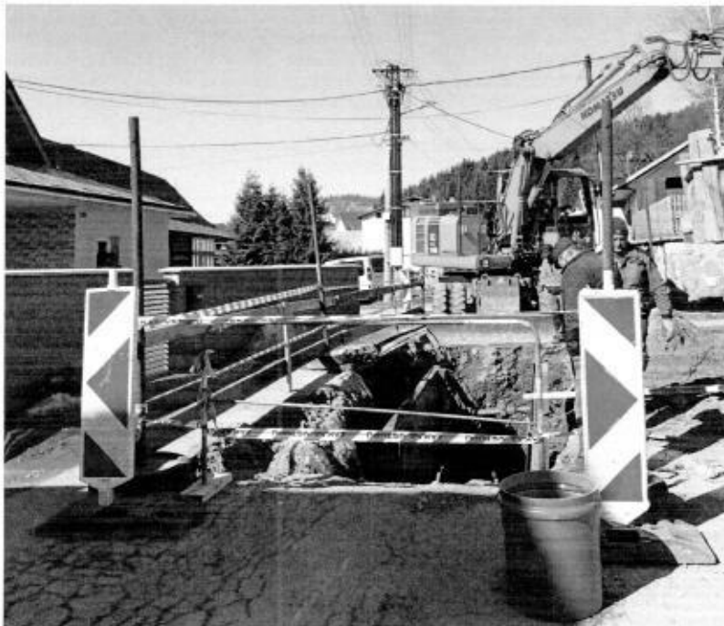
Výstavba kanalizácie v miestnej ceste v rámci projektu spolufinancovaného z európskych fondov IROP „Budovanie verejnej kanalizácie v obci Breza“.
