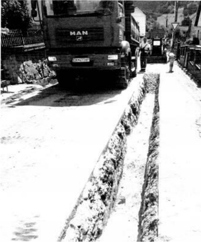
Rekonštrukcia vodovodu v dĺžke 306 metrov na ulici MDD v Dolnom Kubíne.
