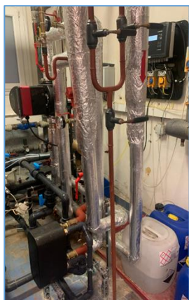
Obrázok 12: Zrekonštruované merače a termohlavice
