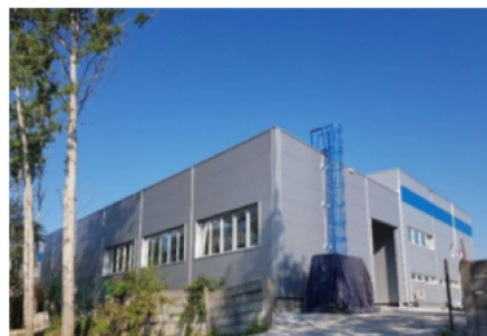
Prístavba k výrobnéj hale – kolaudácia 11/2022
